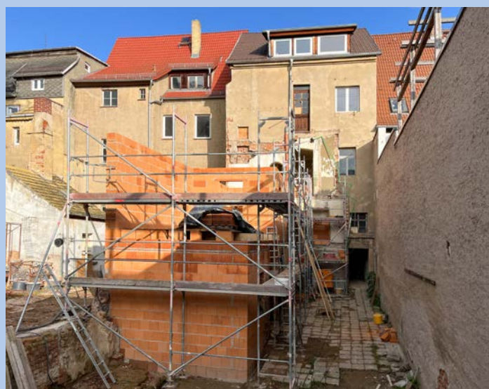
Erneuerung des Seitenflügels Johannisstraße 47 zum Erhalt der baulichen Kante des Martinsgässchens
