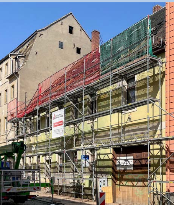
Notsicherungsarbeiten zum Erhalt des Gebäudes Johannisstraße 8
