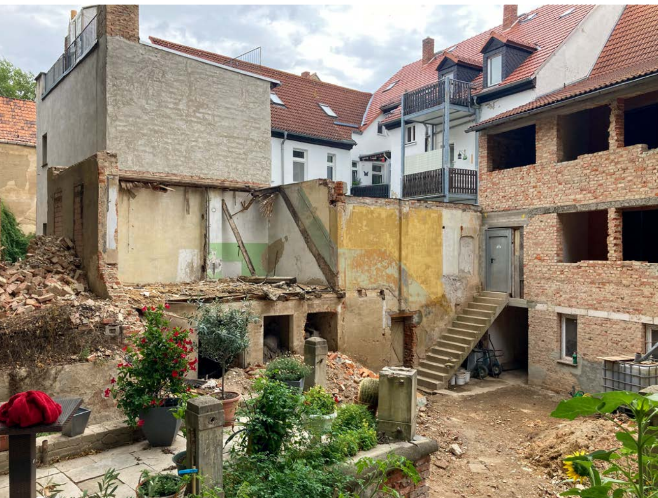
Beginn der Umbauarbeiten
